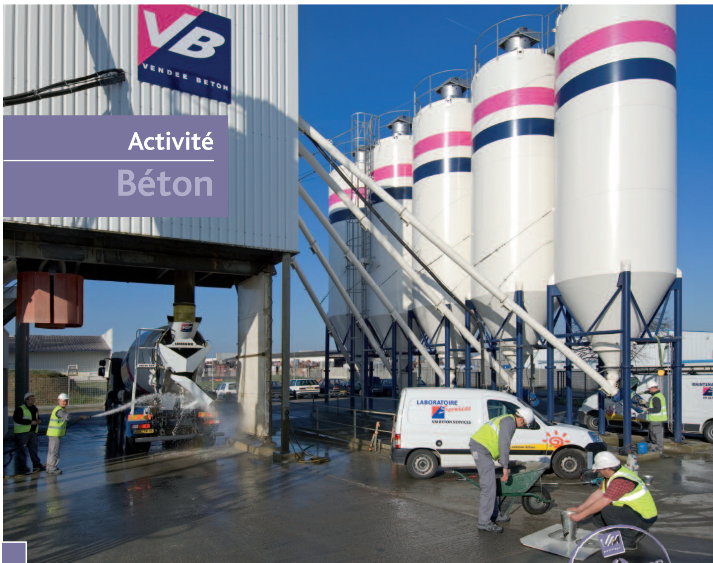
La centrale de Boufféré (85)
