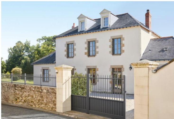
Portail Moulin et clôture Arcade Crédit photo CHARUEL
