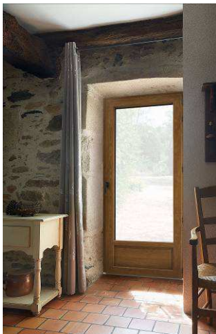
Porte-fenêtre plaxée ton bois, en rénovation Crédit photo : Studio D3
