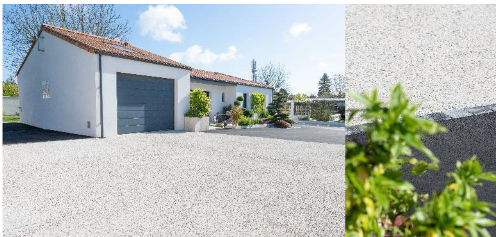
Aménagement extérieur en béton Lumiliss® Désactivé d'EDYCEM - Crédit photos Charles Marion
