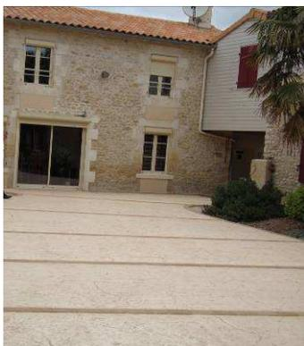
Ce béton d'extérieur d'aspect imprimé est obtenu par la mise en place en surface du béton frais d'une matrice ou peau polymère. Après application d'un colorant durcisseur de surface et d'un agent de démoulage, ces matrices ou ces peaux permettent une déclinaison de textures multiples : aspect pierre, vieux pavés, dalles romaines...
