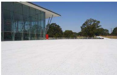
Ce béton, dédié aux environnements extérieurs, peut être coloré. Il est composé de granulats locaux spécifiques choisis pour leurs qualités esthétiques et rendus visibles par l'érosion de surface grâce à un processus de bouchardage mécanique. Sa surface rugueuse laisse apparaître les variations du squelette granulaire.
