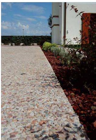
Cette chape à base de ciment, de finition béton à désactiver, est applicable sur des supports stables, durs et structurels à partir de 4 cm d'épaisseur. Particulièrement adaptée à la rénovation d'aménagements extérieurs, elle est conçue à partir de granulats multiples. Elle permet une coloration dans la masse pour se marier harmonieusement à son environnement.
