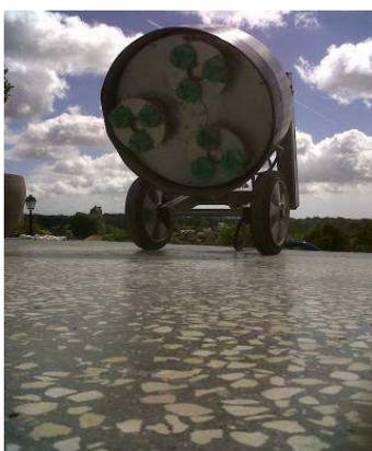
Ce béton peut être mélangé de plusieurs types de granulats, être coloré ou rester à l'état naturel. Il est érodé en surface grâce à un polissage mécanique qui laisse apparaître les effets du squelette granulaire. Le polissage offre une surface plus ou moins lisse, définie selon l'application, intérieure ou extérieure.
