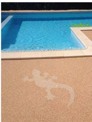
Breveté par la société VM BÉTON SERVICES, ce système conjugue les avantages d'un béton drainant à celui d'une résine décorative liée à des granulats sélectionnés. Il permet de réaliser des sols décoratifs extérieurs drainants pour les descentes de garage, parvis, plages de piscine... Constitué d'une dalle en béton drainante, il hydrate naturellement les sols et laisse s'infiltrer l'eau de surface.
