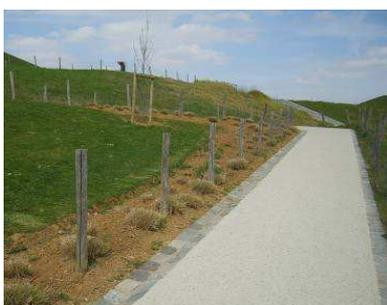
Ce sable stabilisé pour aménagement extérieur offre un aspect naturel. Sa mise en œuvre nécessite un nivellement soigné par finisseur, règle ou raclette en respectant l'écoulement normal des eaux de pluie.
