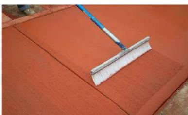
Ce béton, pouvant être coloré, est travaillé en surface à l'aide d'un balai nylon. Celui-ci permet d'obtenir une gravure esthétique améliorant l'adhérence et offrant de l'originalité aux extérieurs.
