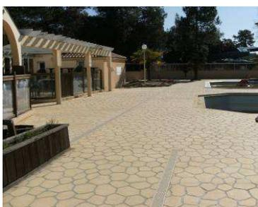
Ce béton destiné aux extérieurs est imprimé par la technique du pochoir. Il est réalisé par la mise en place d'une trame en carton hydrofuge qui permet la matérialisation des joints, le saupoudrage et l'application d'un colorant durcisseur de surface sur béton frais. La trame se décline en plusieurs finitions, pavés droits, pavés de Paris, dalles romaines...
