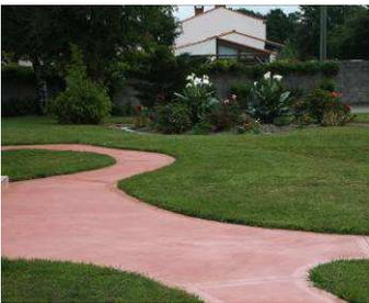
Ocre, jaune, rouge, marron, noir ou encore ton pierre, ce béton teinté dans la masse s'adapte aux ouvrages intérieurs et extérieurs. Afin d'optimiser la tenue de la teinte dans le temps, un produit de traitement préventif, tel qu'un minéralisant, peut être appliqué.
